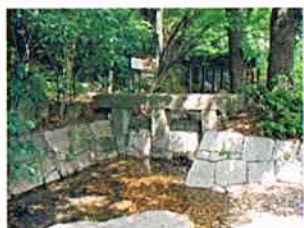
関口大洗堰 取水口の石柱
